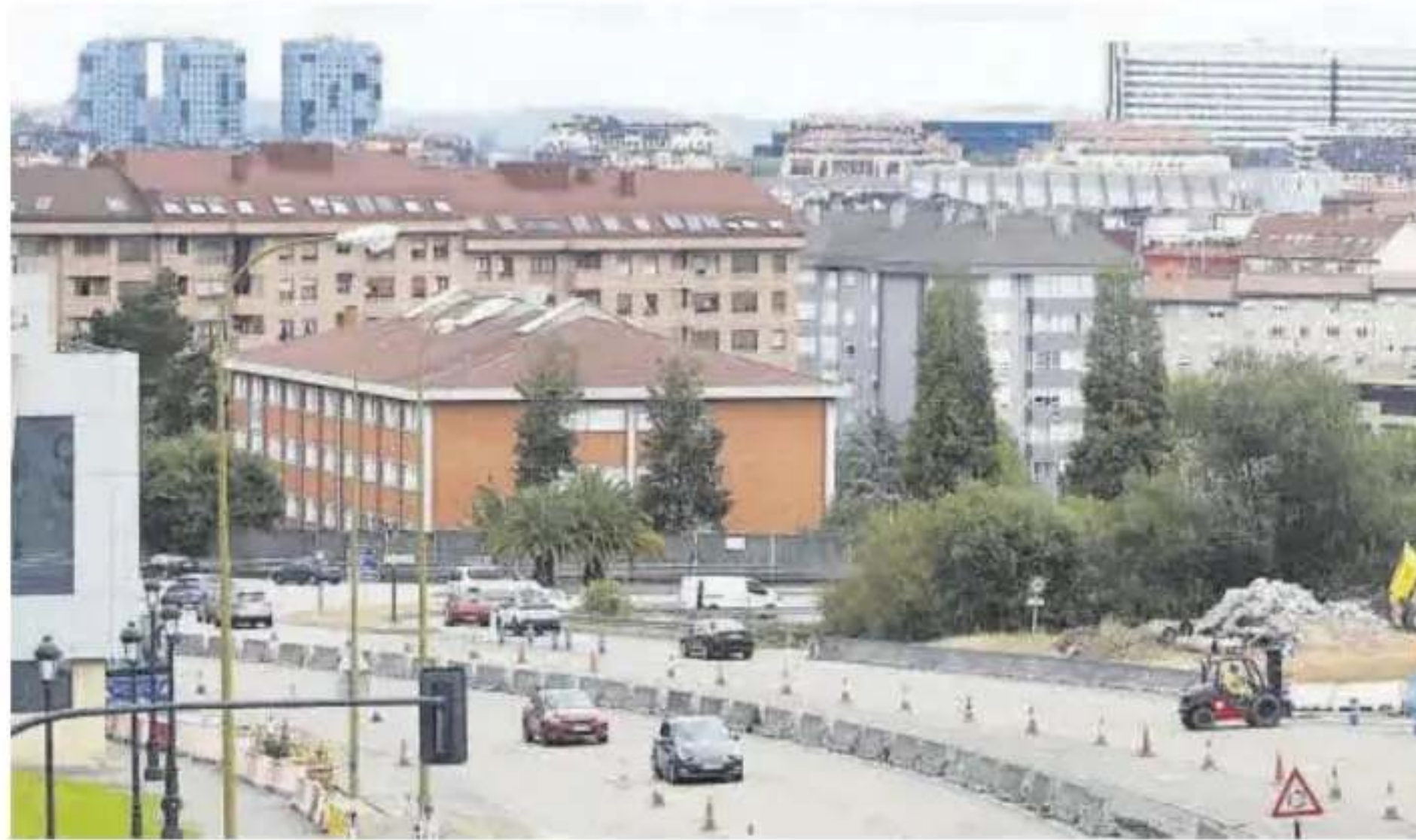
Máquinas trabajando ayer en el tramo de la Ronda Sur que está siendo reformado.
