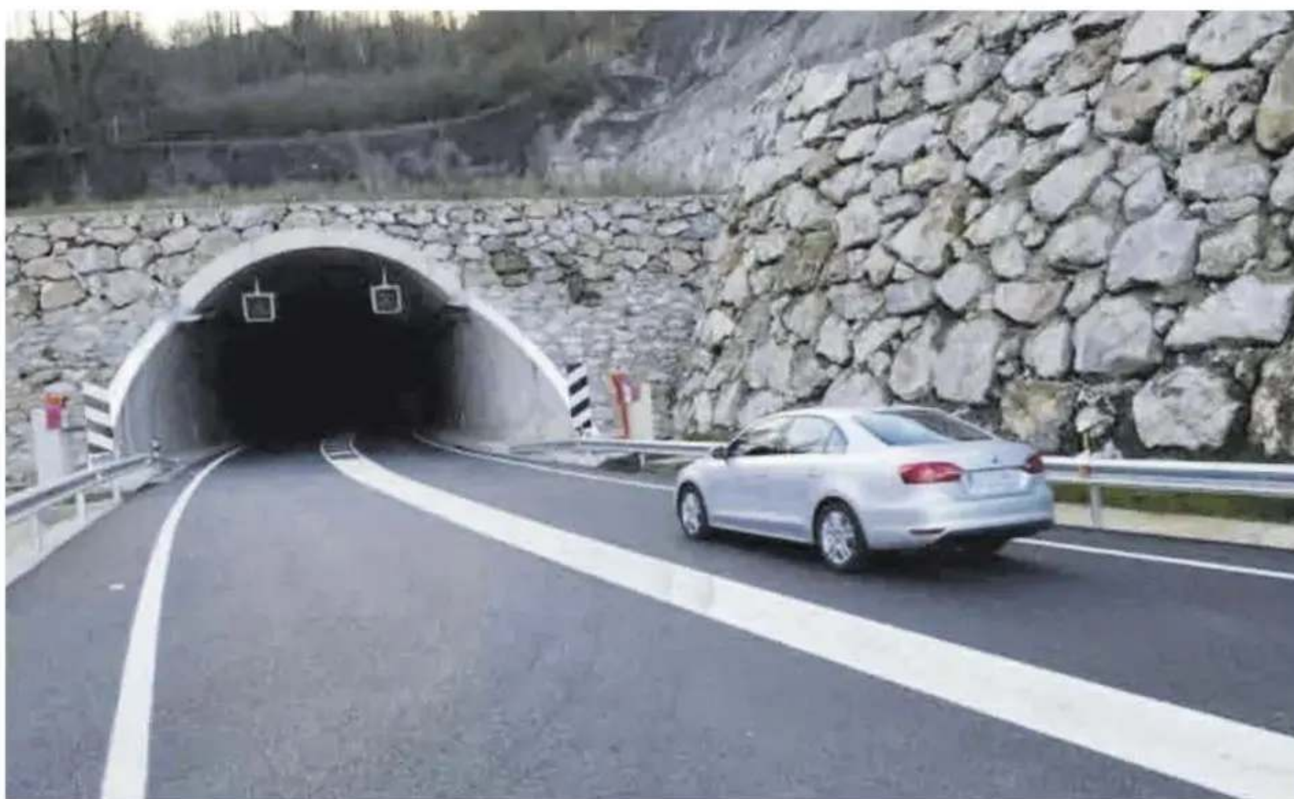
Un vehículo, a la entrada del túnel de El Corbero, en la «Y» de Bimenes.
